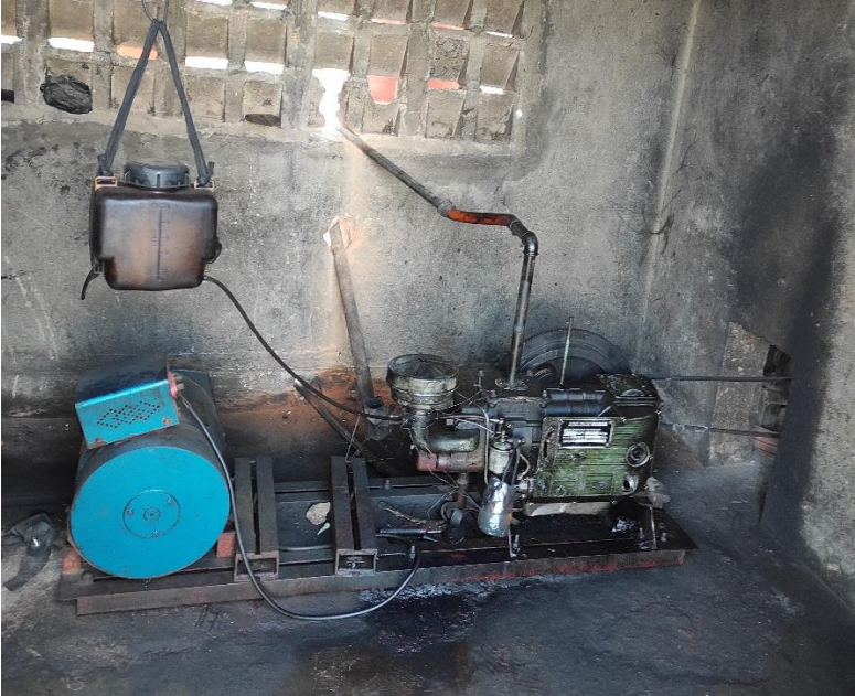
Alternateur + moteur diesel
