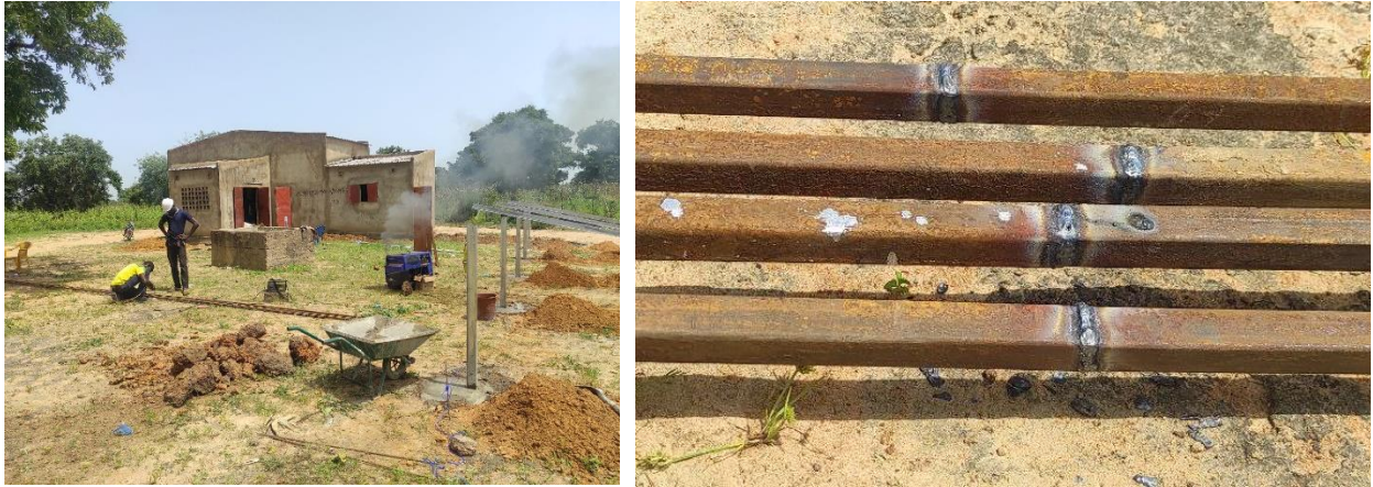
Figure 15 : Soudure et perçage des traverses
