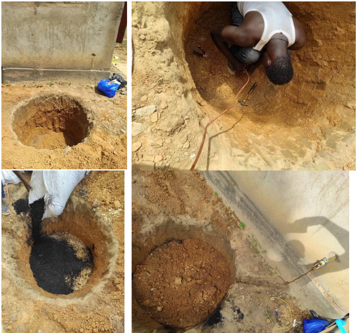
Figure 24 : Étapes de mise à la terre
