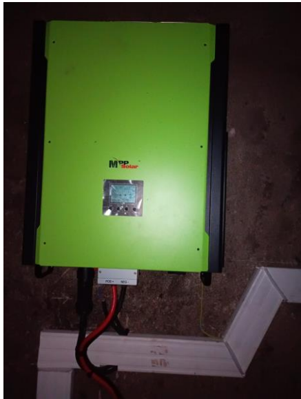
Figure 17 : Onduleur de 10 kW
