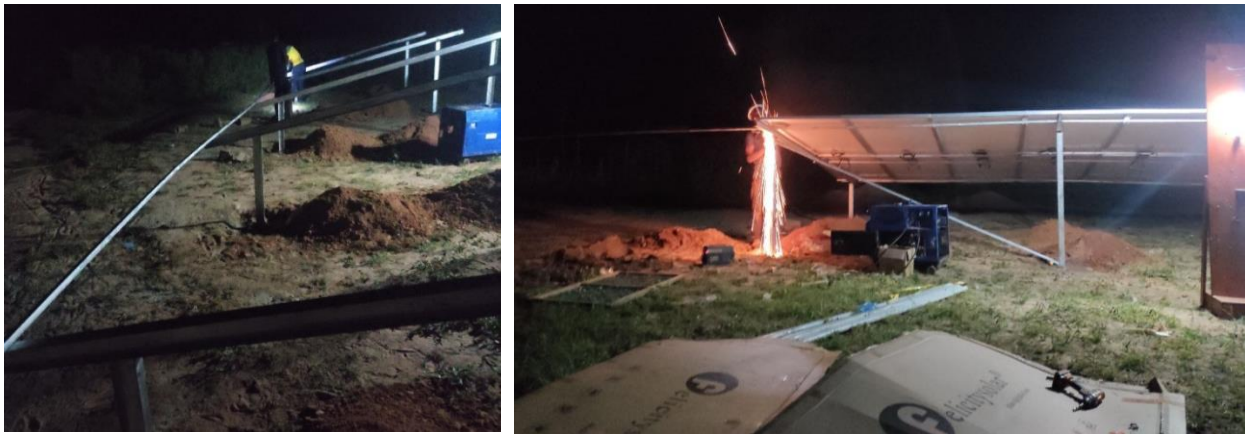
Figure 16 : Soudure des traverses
