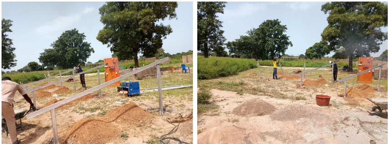
Figure 14 : Soudure des gabarits et préparation des traverses.
