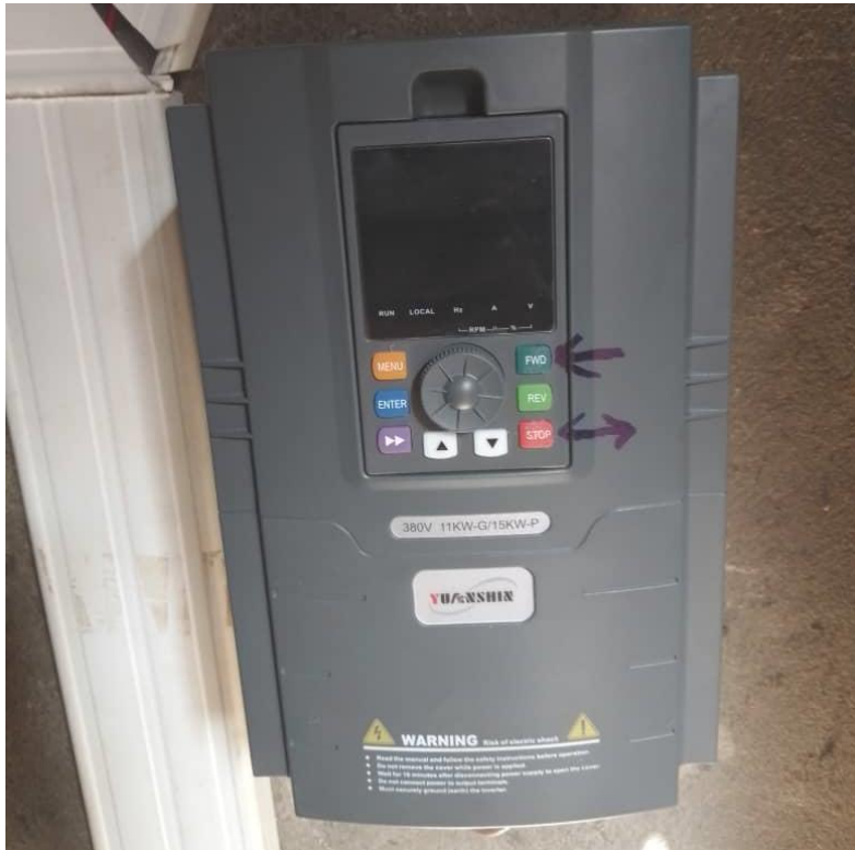
Figure 9 : Variateur de vitesse 11 kW 400V 50Hz IP 20
